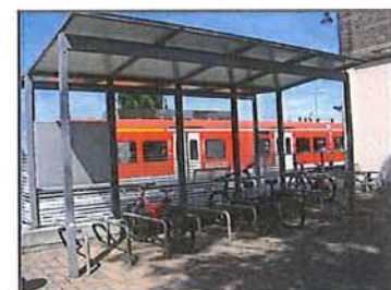
Abstellanlagen am Bahnhof Bruchmühlbach-Miesau
