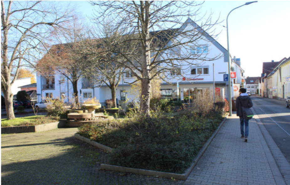
Abb. 18: Ansicht aus Nord-West: Aktuelle Bepflanzung und Zugang von Hauptstraße
