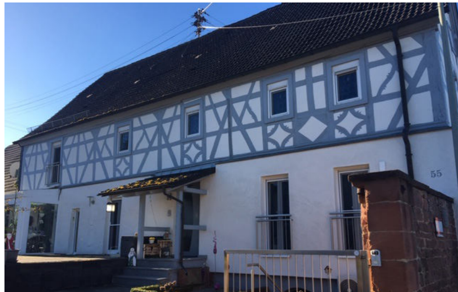
Abb. 55: Sanierung des historischen Gebäudebestands
