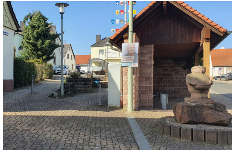
Abb. 23: Ansicht von Süden: Hohlwampe, Bushaltestelle und Zugänge (Bild: Haager)
